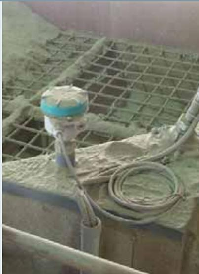
El sensor de nivel versátil Pointek CLS200 detecta el nivel de llenado alto o bajo con materiales líquidos, sólidos, lodos y espuma. Es idóneo también para control de bombeo y de interfaces, o como complemento de instrumentos de medida continua de nivel en presencia de cargas químicas y mecánicas.
