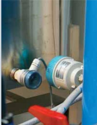
Pointek CLS100 es ideal para detección de nivel en espacios limitados, interfaces, sólidos a granel, líquidos, lodos y espuma. Preciso, económico, fiable, y fácil de instalar. Esta sonda de longitud corta (100 mm, 4") constituye una solución ideal para detectar niveles de llenado altos/bajos o intermedios en tanques o depósitos.
